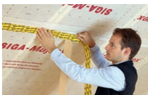
Solapamiento de barreras de vapor
