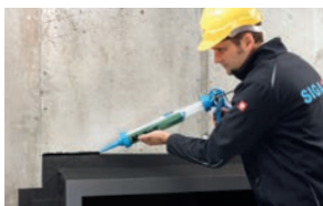
Sellado de fugas, fisuras, penetraciones
