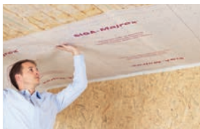
Instalación de barreras de vapor
