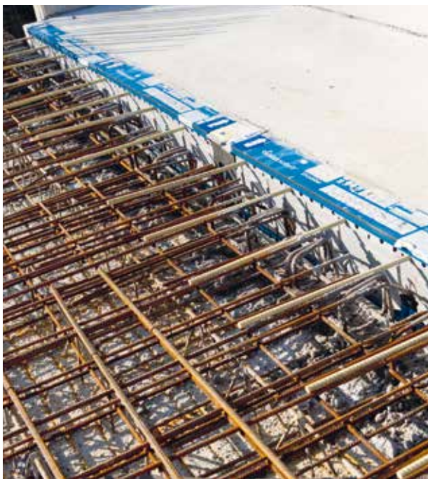
Montaje del balcón prefabricado en la obra.
