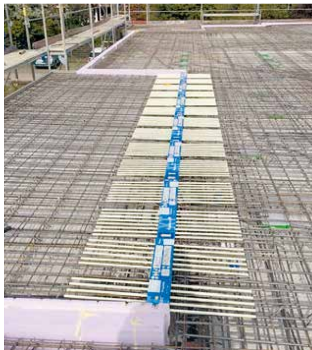
Schöck Isokorb® CXT tipo K para el uso en hormigón elaborado in situ.
